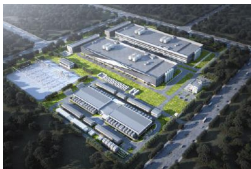
秦准数据集团马来西亚数据中心
